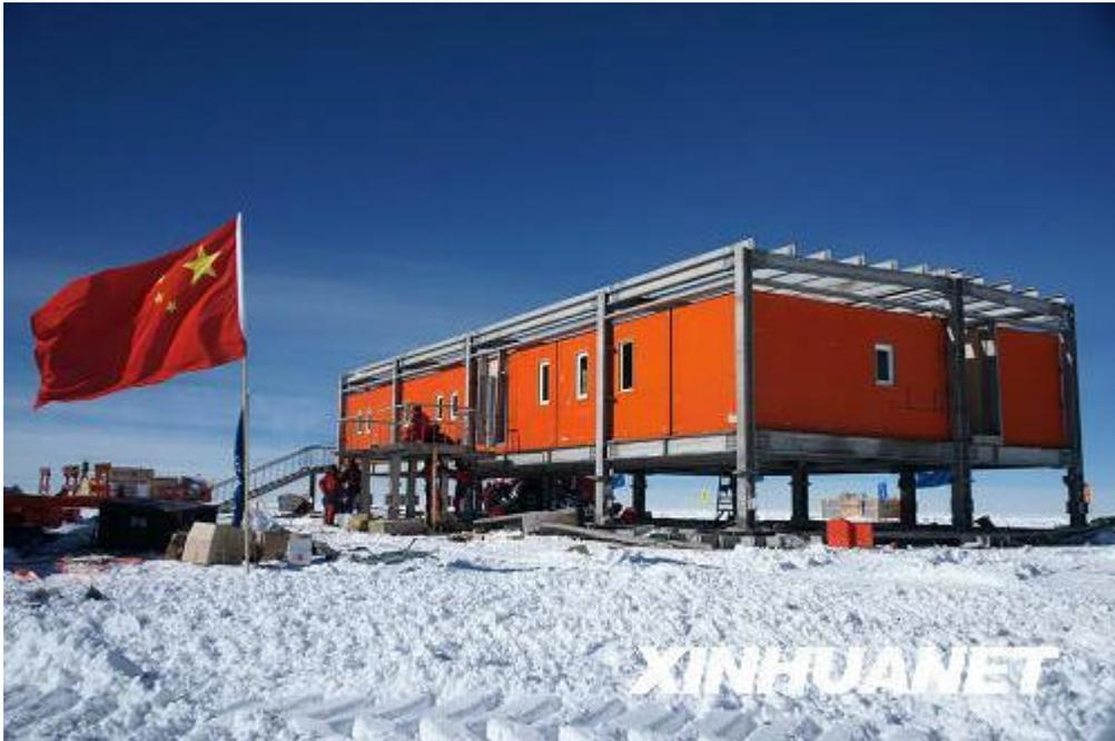
1月15日从中国第25次南极科考队内陆冰盖考察队获悉，中国第一个南极内陆科学考察站——昆仑站的建设工程进展顺利，主体建筑钢结构已经搭建完毕，内部所有11个工程舱也吊装就位。昆仑站主体建筑工程项目采用的是国内预制与现场安装结合的建造方式，即在现场搭建的架空钢结构中安装集装箱式拼接建筑，在拼接建筑外面再安装一层夹芯保温板。为了保暖，集装箱壁也具有复合保温层。
