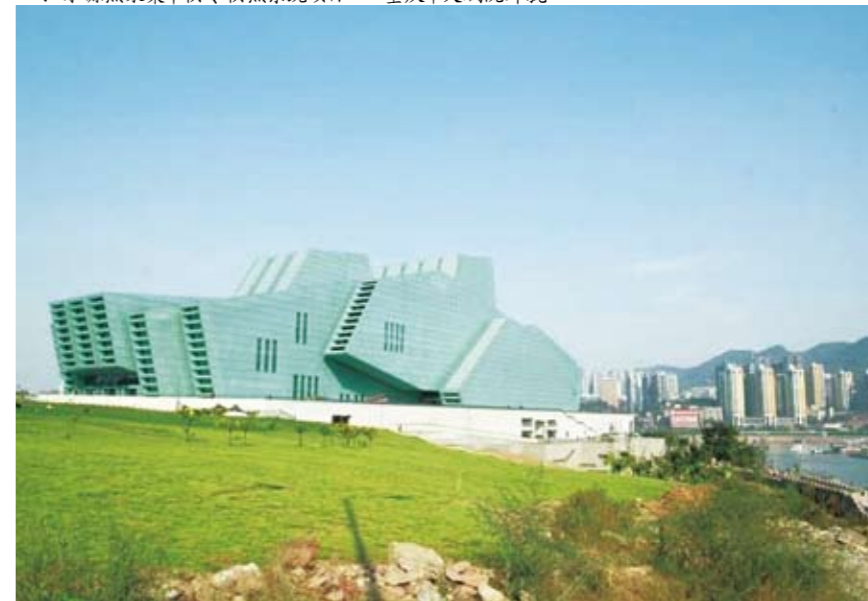
● 江水源热泵集中供冷供热系统项目——重庆市大剧院外貌
