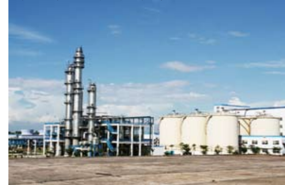
● 广西北海20万吨/年木薯燃料乙醇项目现场
