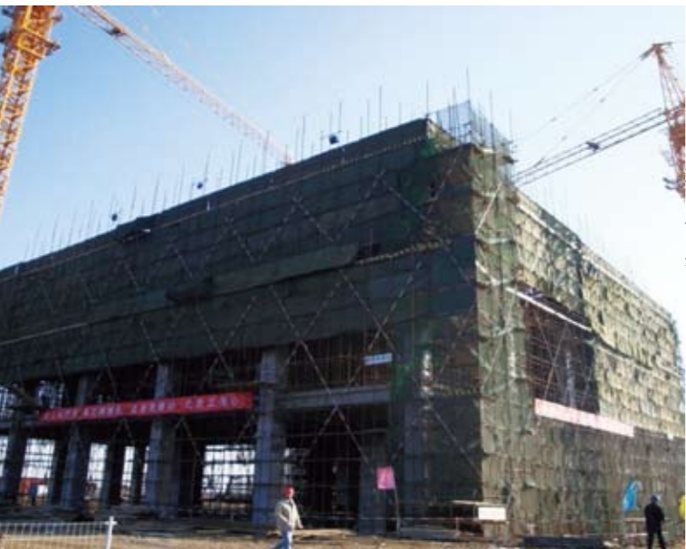
●天津市IGCC电站煤气化系统
