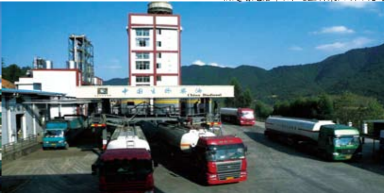
● 福建省龙岩市7万吨生物柴油项目现场
