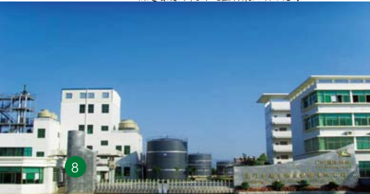
● 福建省厦门市5万吨生物柴油项目现场
