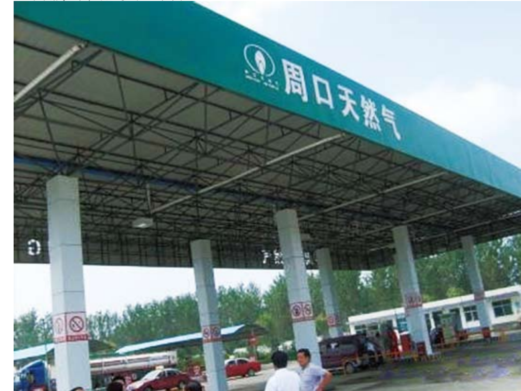
● 河南省周口市车用燃气工程现场图片
