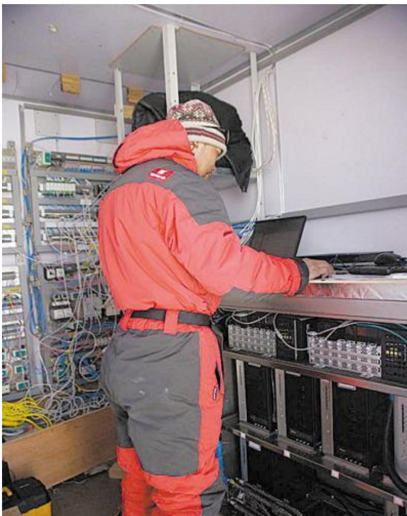
科研人员在调试设备。
