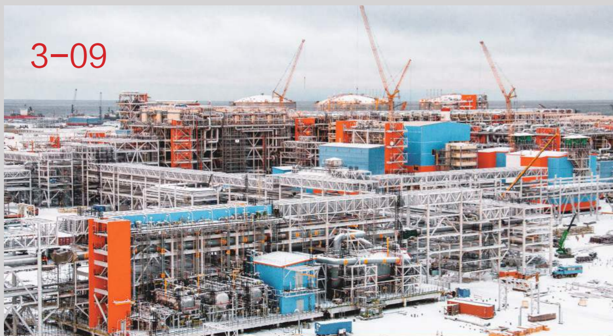
亚马尔 LNG 项目是中国与俄罗斯合作的最大的海外油气合作项目。2014 年，中国国家开发银行、中国进出口银行作为亚马尔 LNG 项目提供 120 亿美元的等值融资支持，及时改善了亚马尔液化天然气公司净资产状况，成为“一带一路”资金融通的经典范例。图为亚马尔 LNG 项目建设现场。
