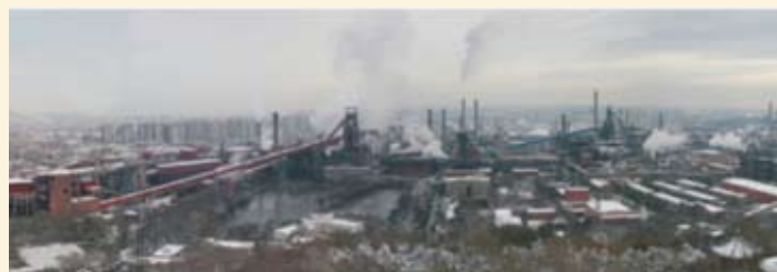
首钢搬迁前厂貌
